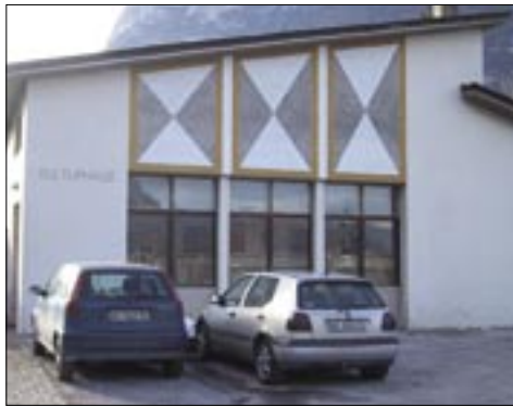
Abriss und Neubau
