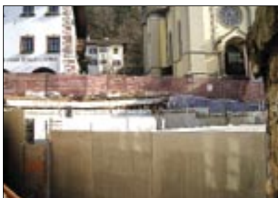
Die Tiefgarage nimmt Formen an
