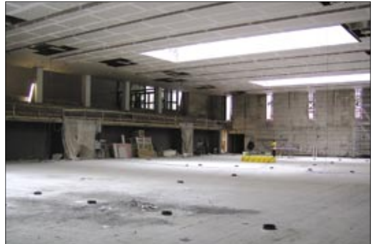
Bauabschluss in Sicht
