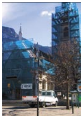
Baugeriist an der Kirche
