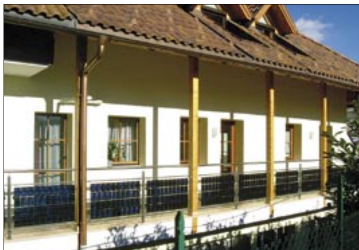
Die Flexible Anbringung von Energieträgern eröffnet neue Möglichkeiten
