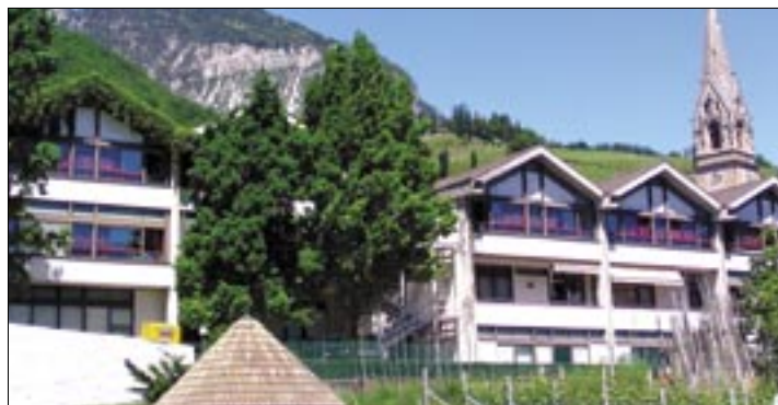
Das Mittelschulgebäude wird saniert
