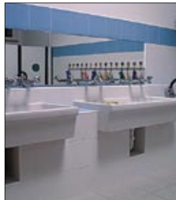
Funkelnagelneue Waschräume Foto: IA
