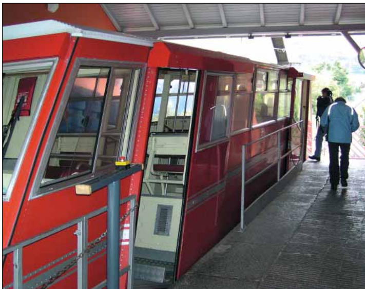
Mendelbahn: Entlang der Trasse der Mendelbahn werden Sanierungsarbeiten durchgeführt werden Foto: SM
