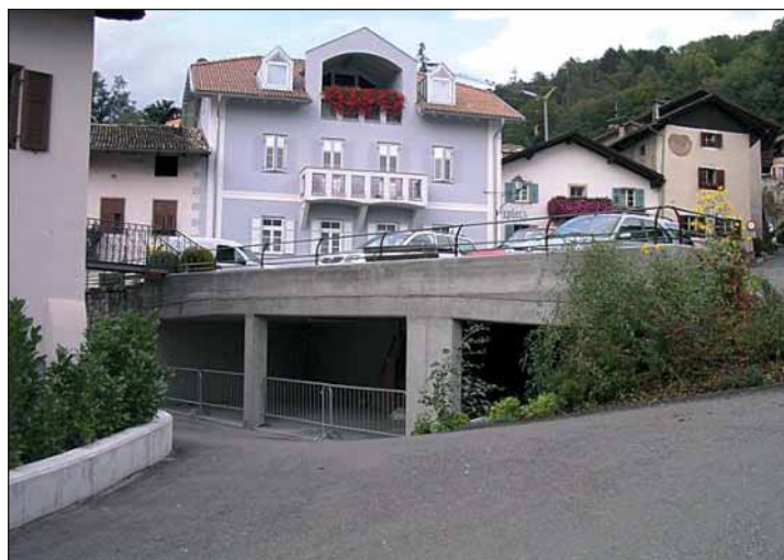
Klein aber fein: die neue Tiefgarage
