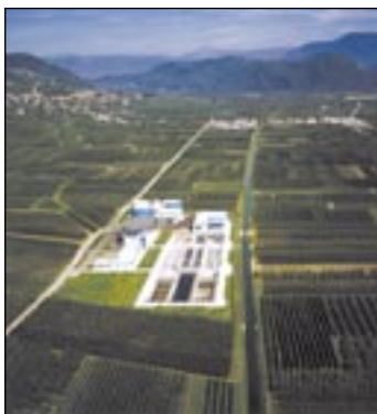
Luftaufnahme der Bezirkskläranlage in Tramin Foto: Archiv des Abwasserverbandes
