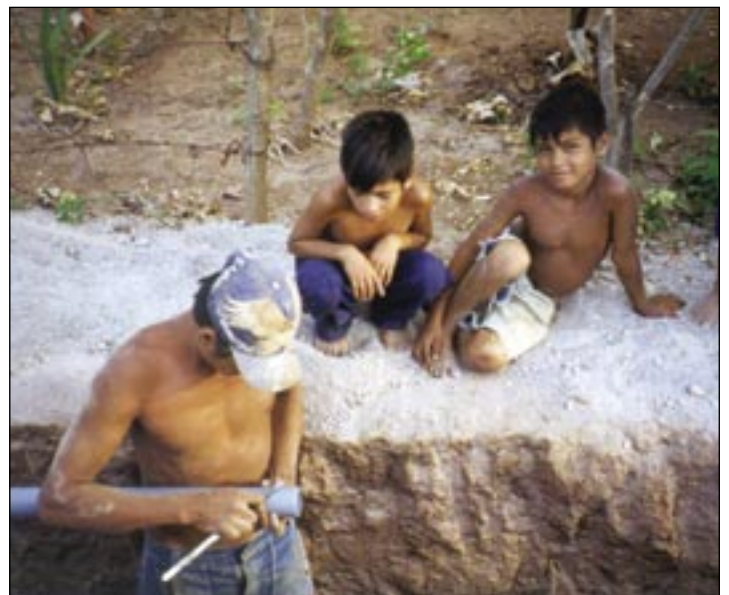
Hilfe beim Bau einer Wasserleitung
