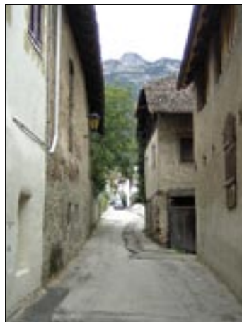
Historische Gebäude entlang des St.-Anna-Weges. Foto: SH
