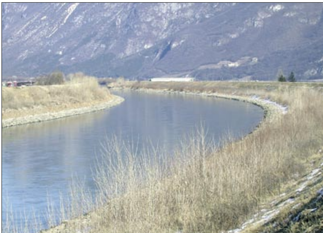
Der Etschdamm in Richtung Norden von der Etschbrücke Salurn aus fotografiert
