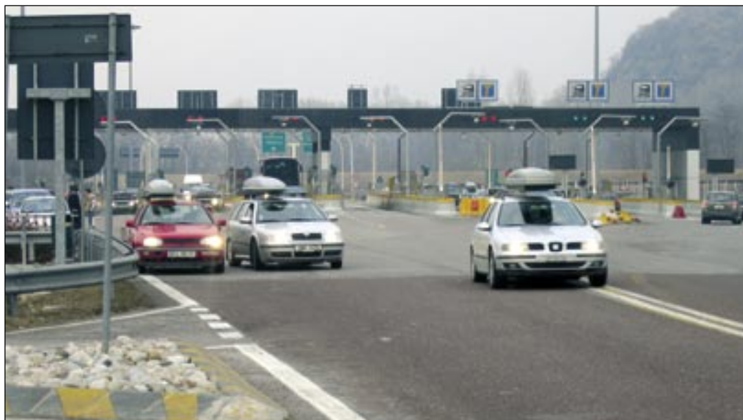
Die stark benutzte Autobahn Ausfahrt Neumarkt/Auer
