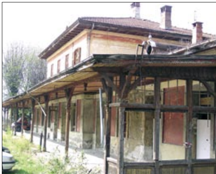
Der ehemalige Bahnhof soll multifunktional genutzt werden
