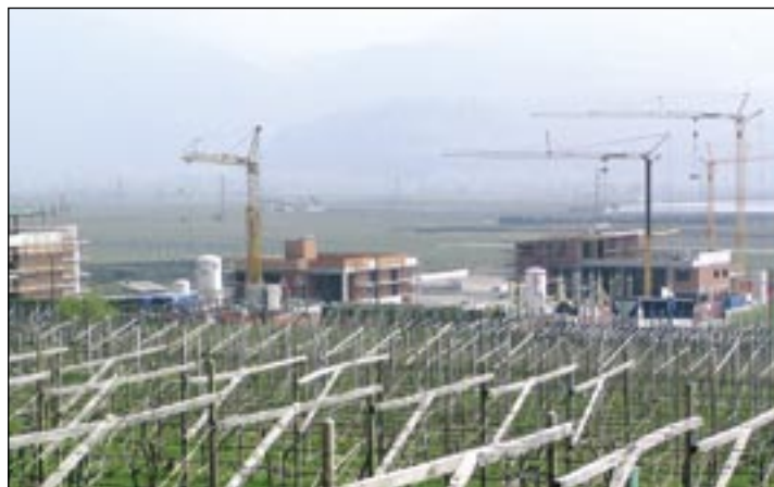
Bautätigkeit in der neuen Handwerkerzone „Steinacker“.
