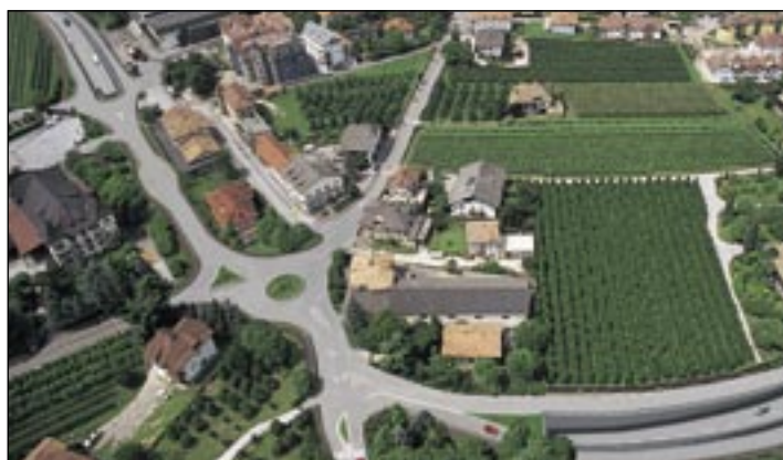
Untertunnelung Bahnhofo Kreuzung
