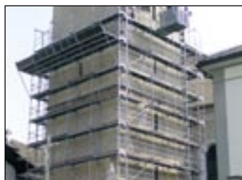
Der Pfarrturm wird gerade in ein Gerüst verpackt.
