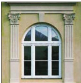
Für diese besonderen Anforderungen hat Finstral ein spezielles Altbaufenster entwickelt. Der alte Rahmen bleibt als Blindzarge im Mauerwerk, der neue Finstral-Rahmen wird einfach und sicher aufgesetzt. Anschlussprofile decken die Fuge außen- und raumseitig ab.
