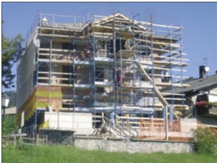
Die Arbeiten am neuen Widum gehen zügig voran
