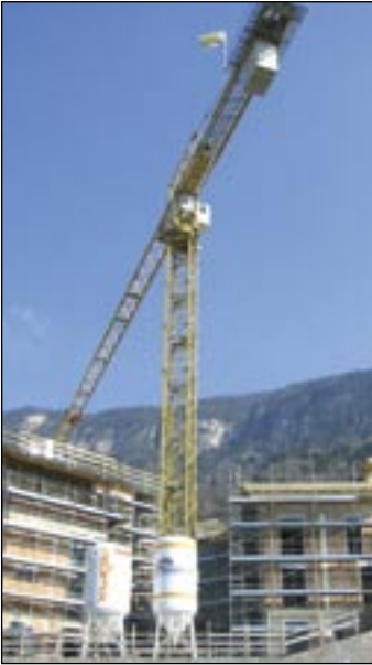
Eine der vielen Baustellen von Bernard-Bau: Weingütl in Montan Foto: KT
