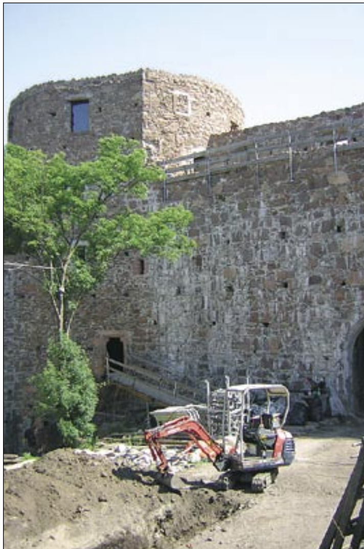
Hier im Schloss-Innenhof wird ein Amphitheater gebaut
