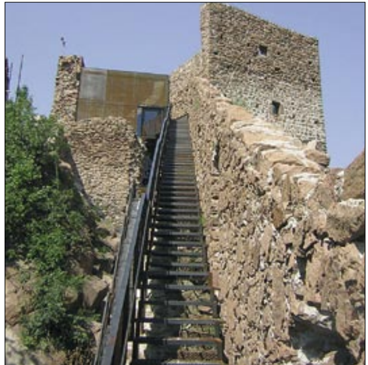
Die rostfarbenen Stahltreppen fügen sich gut in den Schlosskomplex ein Foto: CB
