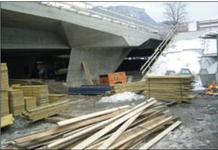
Betonpfeiler tragen das Sonnendeck
