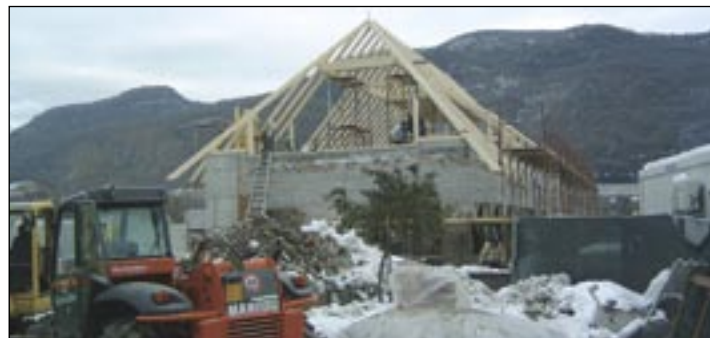
Das Lido-Gebäude bekam ein neues Dach
