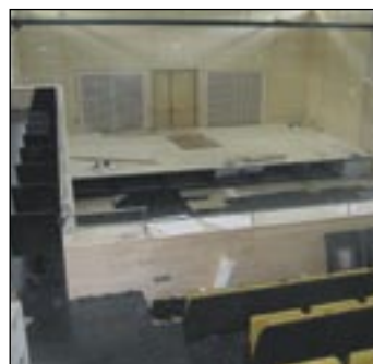
Der neue Konzertsaal kurz vor der Fertigstellung Foto: MD
