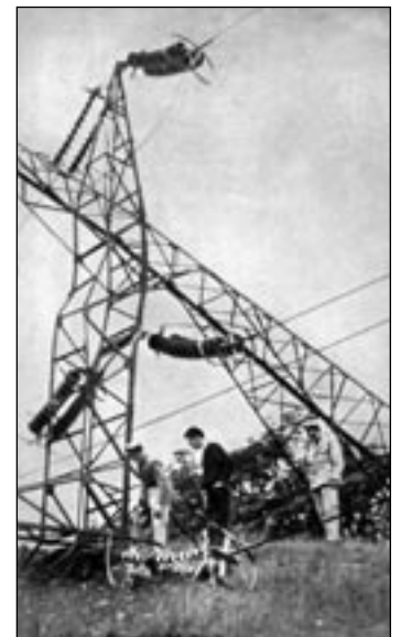
Lahmlegung der Stromversorgung als Zeichen des Unbehagens, das war das erste Ziel der Aktionen
