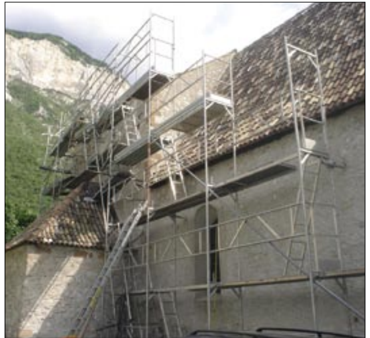
Aufwändige Restaurierungsarbeiten an den Außenfassaden
