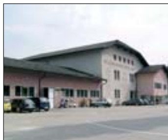
Das Gebäude der Kellereigenossenschaft Tramin wird im Frühjahr 2008 erweitert und neu gestaltet werden. Foto: SM
