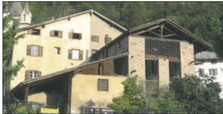
Noch in diesem Jahr soll mit den Abriss- und Bauarbeiten des Altenheims Lisl-Peter begonnen werden. Foto: KT
