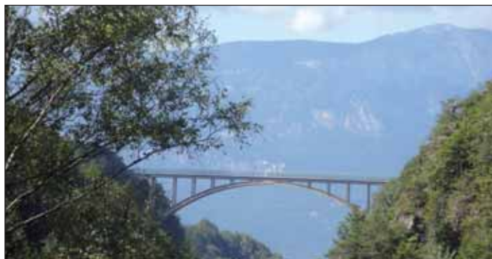
Seit 1964 verbindet die Aldeiner Brücke die zwei Talseiten und Holen ist kein Durchzugsgebiet mehr. Foto: KT
