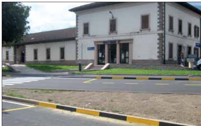
Mehr Übersicht durch die Neugestaltung am Bahnhof Auer.
