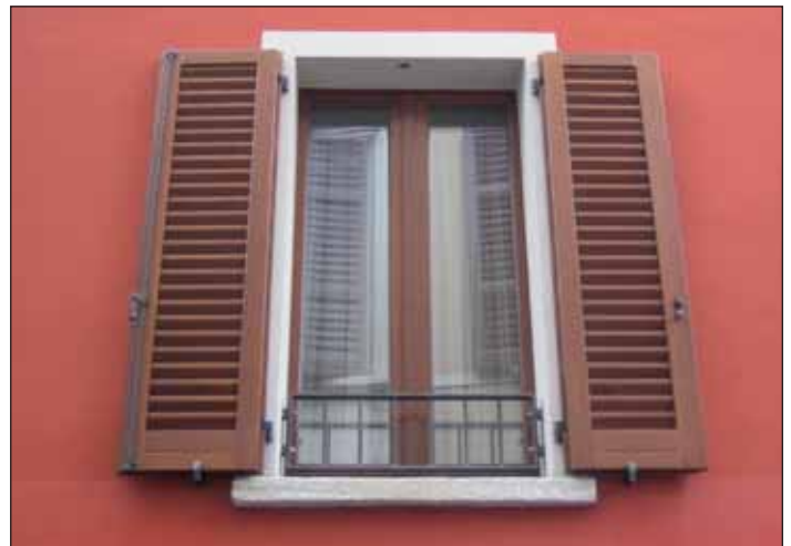
Besser kurz und ordentlich lüften, als Fenster stundenlang gekippt zu halten.
