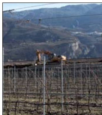
Bau der Lärmschutzwände nach dreijährigem Warten. Foto: RM
