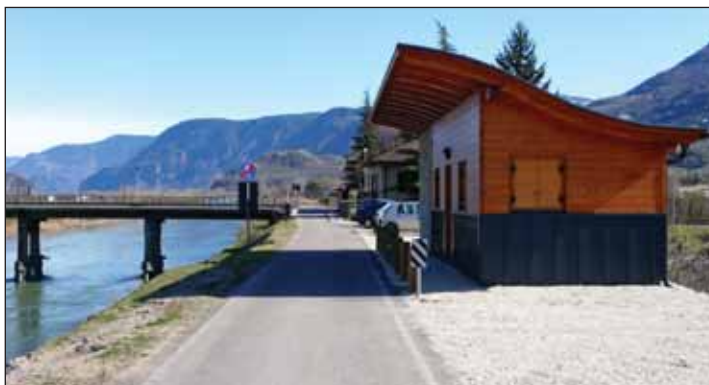
Die neue Flussbeobachtungsstelle in Neumarkt soll in Kürze in Betrieb genommen werden
