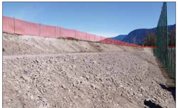
Gerade werden Verstärkungsarbeiten des Deiches beim Sportplatz in Neumarkt durchgeführt,
