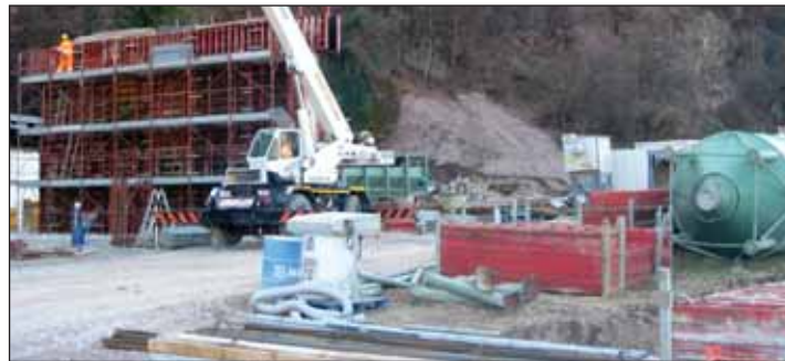
Am Nordportal der Aurer Umfahrung wird bereits fleissig gearbeitet. Foto: TK
