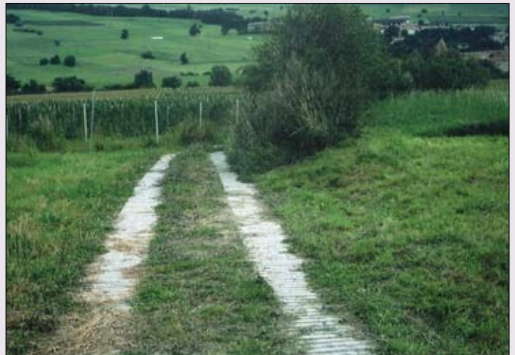
Betonspurweg mit Rillen als Alternative zum Asphalt in Glurns/Vinschgau
