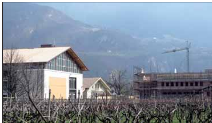
Im Herzen Kurtinigs: Die bereits fertiggestellte Mehrzweckhalle und der Rohbau des Feuerwehrgebäudes
