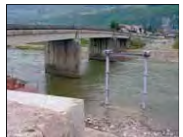
Spuren der Behelfsbrücke, die im Winter über die Etsch führen wird Foto: KS
