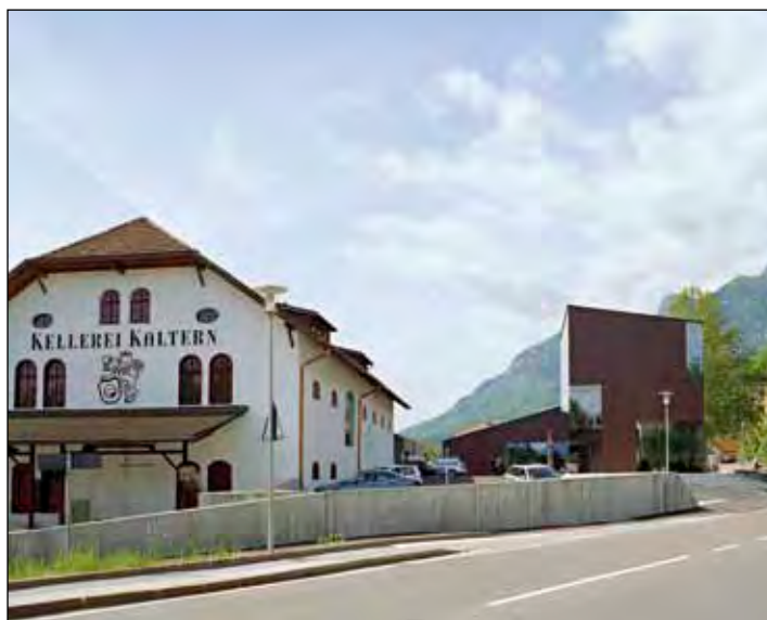
Kellerei Kaltern mit winecenter
