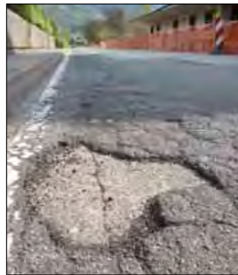
Noch gibt es in der Bahnhofstraße etliche Schlaglöcher Foto: CB
