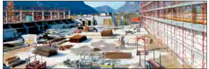
Die Bauarbeiten gehen zügig voran
