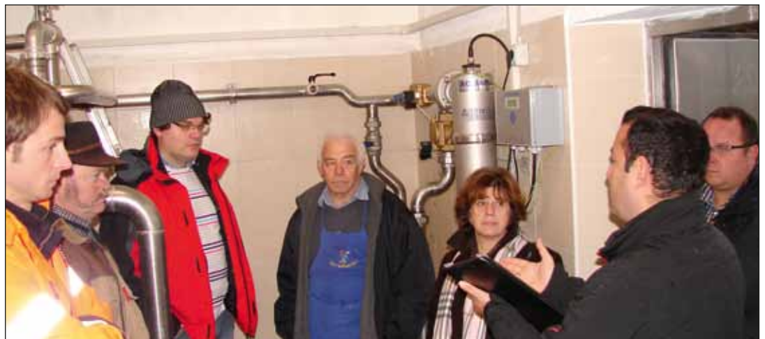
Geom. Uwe Zwerger vom Ingenieurbüro Baubüro Bozen erläutert den Anwesenden die Vorteile der neuen Wasserleitungen
