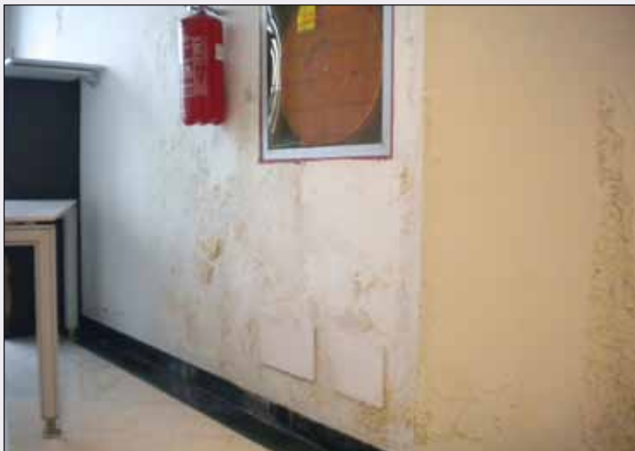
Wasserschäden im neuen Haus
