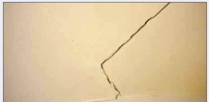
Setzungsrisse durchziehen das Gebäude
