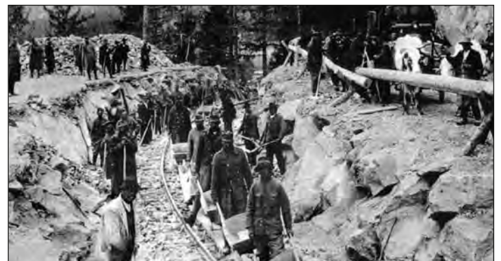
Von den 6.000 Arbeitern die am Bau der Fleimstalbahn beschäftigt waren, waren 2.100 Militärpersonen und 3.600 Kriegsgefangene Alle F: Luis Walter
