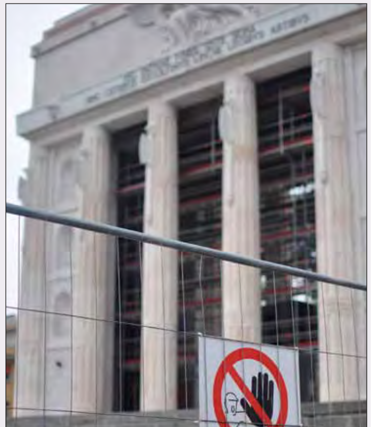
Das Siegesdenkmal hinter dem Absperrungszaun: Mitten in die Renovierungsmaßnahmen platzte der von Bondi zugesicherte Baustopp F: CW
