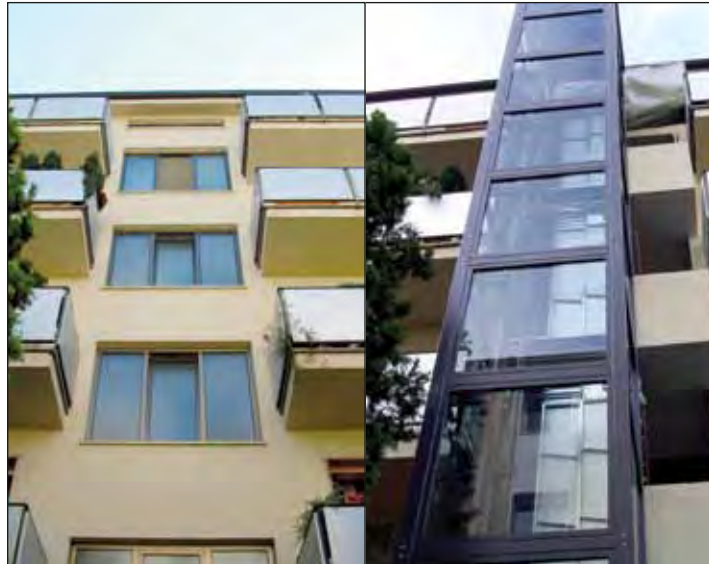
Vor (l.) und nach (r.) der Nachrüstung
