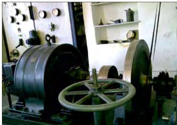
Dieser Stromgenerator aus der Zeit der k. k. Monarchie versorgte einst ganz Kurtatsch und Margreid.
