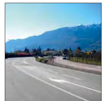
Die Vorarbeiten für die provisorische Straße in Richtung Dorf (rechts) sind abgeschlossen
