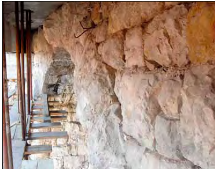
Die alten Bögen werden vom Zubau aus den 50ern verdeckt F: Elmar Morandell
