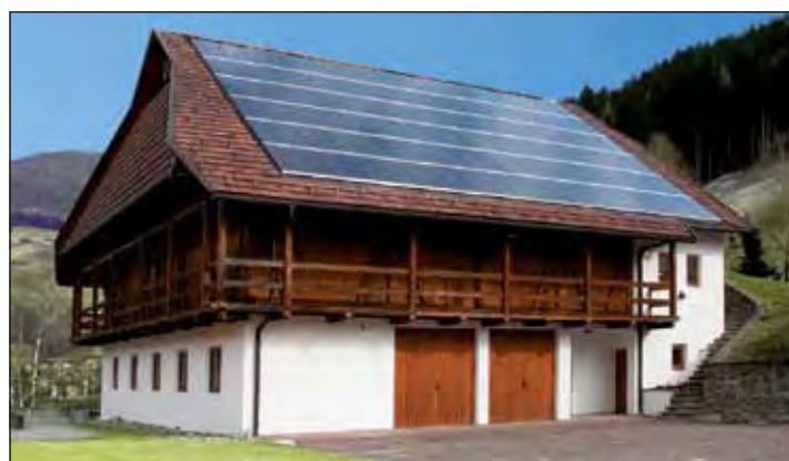
Ansitz mit Photovoltaikanlage
