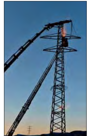
Zuerst wurden die Arme des Mastens abgesägt, dann wurde der gesamte Eisenkoloss kontrolliert gefällt.
