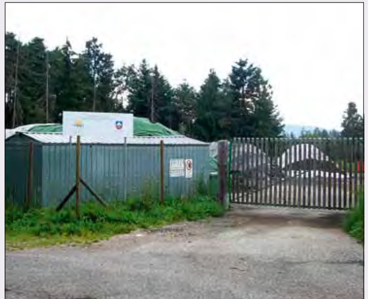
Die Kompostieranlage in Aldein
