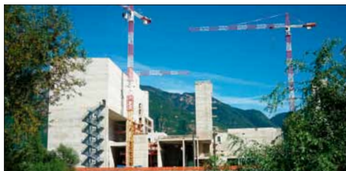
Müllverbrennungsöfen in Bozen Süd
