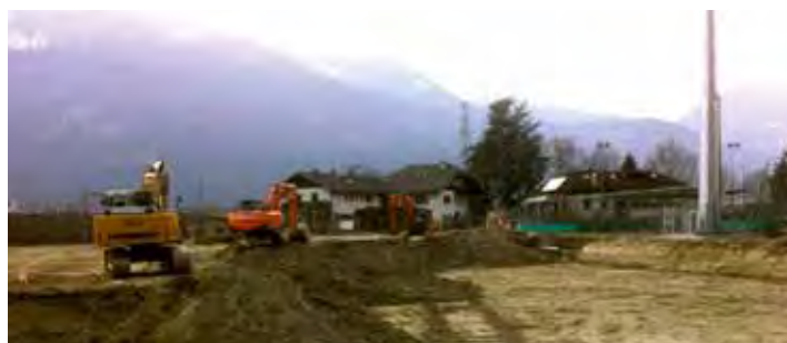
Bei den Tennisplätzen entsteht der neue Eislaufplatz F: AK
