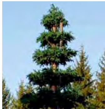
Viele Mobilfunkantennen werden als Bäume getarnt, um in freier Natur nicht störend aufzufallen. F: Dr. Dietrich Moldan
