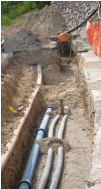
Erst im Oktober werden die Arbeiten abgeschlossen. F: MS
