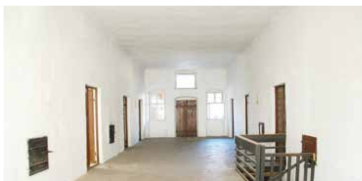
Die Mittelhalle wurde in der spätbarocken Ausbauphase des Gebäudes um 1740/50 angelegt und durchsticht das Gebäude in seiner gesamten Tiefe (17,80 m)
