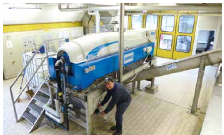
Dekanter Kläranlage Branzoll
