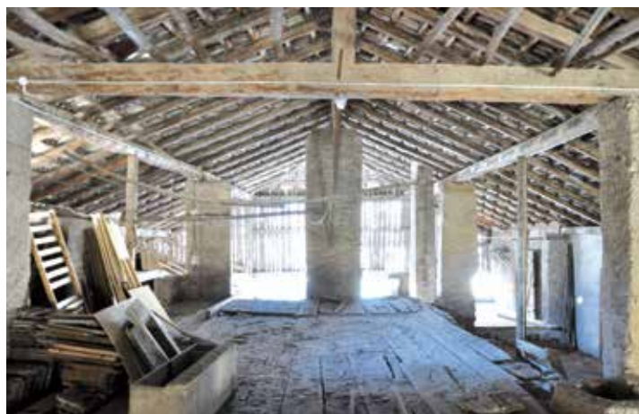
Dachraum vor der Sanierung
