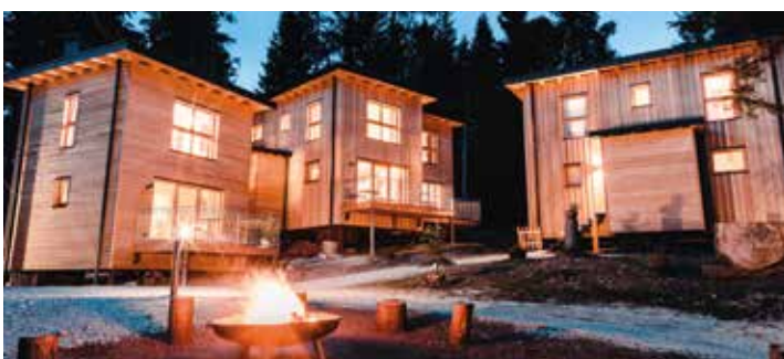
Jedes der sechs Massivholz-Chalets ist ein Unikat.
