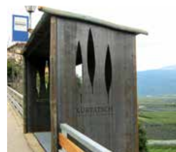
Das über die Felswand auskragende Wartehäuschen. F: Martin Schweiggel
