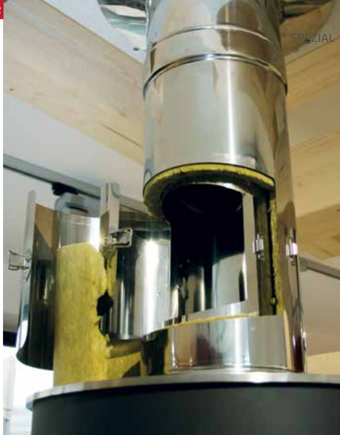
~ Muster eines Kamins, der absolut sicher durch brennbare Baustoffe führt
