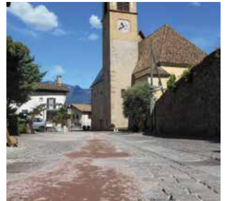
^ Die Verlegung der Glasfaserkabel ist noch deutlich sichtbar. Foto: Christian Bassani
