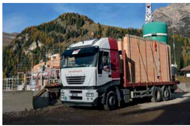
~ Die fertigen Ziegelmauern werden mit allen Elektroinstallationen angeliefert, schnell und trocken montiert und das in 101 Tagen. Quelle: Alp House
