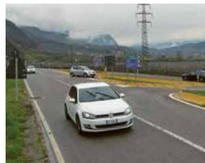
^ An der Weinstraßenkreuzung Richtung Auer-Neumarkt wird ein Kreisverkehr mit Radwegquerung gebaut. Foto: Martin Schweiggel
