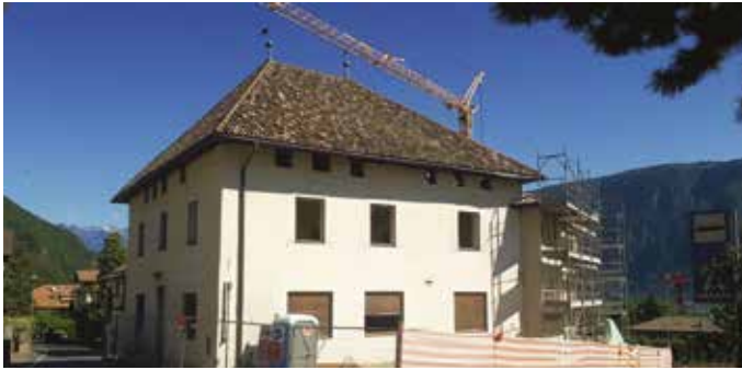
~ Ende des Jahres soll die neue Bibliothek samt Vereinsräumen bezugsfertig sein
