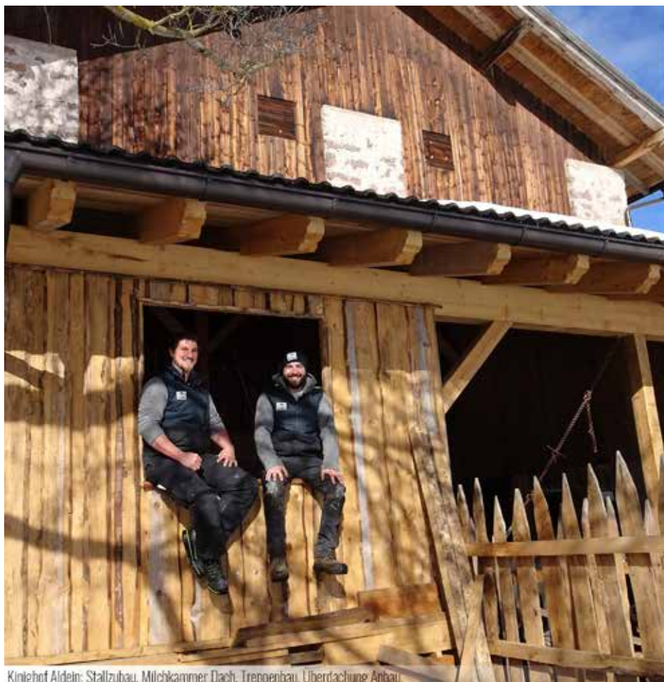
Kinighof Aldein: Stallzubau, Milchammer Dach, Treppenbau, Überdachung Anbau.
