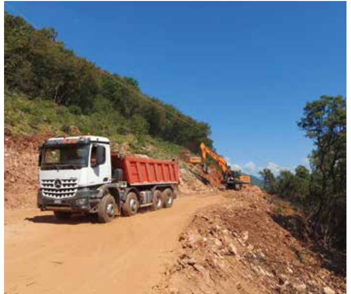
~ Mit schweren Maschinen wird derzeit am Schutzwall für Rungg gearbeitet
