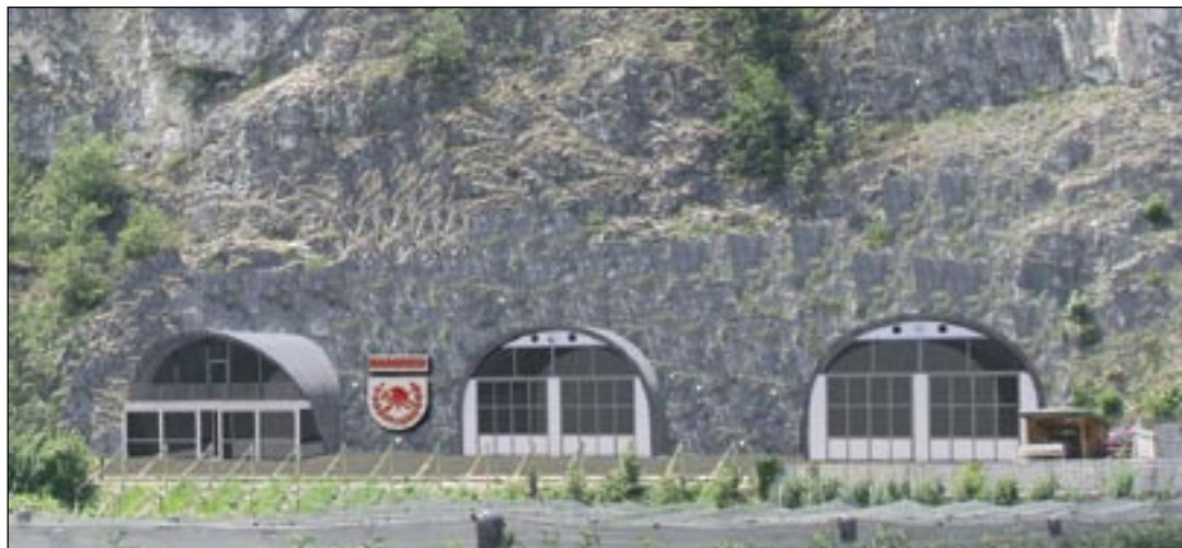
Feuerwehrhaus mit drei 16 Meter langen Tunnelröhren
