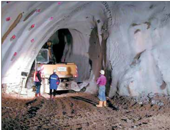
Die Arbeiten am Erkundungsstollen haben bereits begonnen
