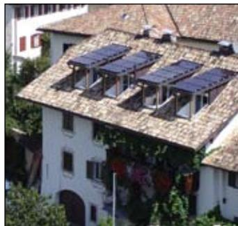
Girlan - integrierte Photovoltaikanlage
