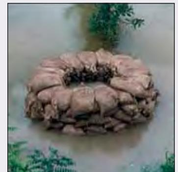
Mit Sandsäcken wird versucht, die Unterspülung des Damms zu verhindern
