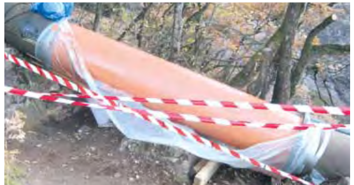
Ein neues Rohr (rötliche Farbe) wird in das alte Rohr eingeschoben
