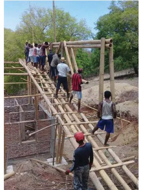
~ Der Bambusrahmen für die Dachkonstruktion wird aufgestellt
