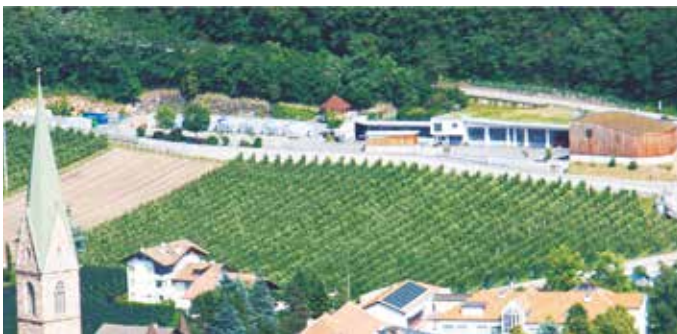
~ Der älteste Wertstoffhof Südtirols wird demnächst umgebaut Quelle: Gemeinde Terlan
