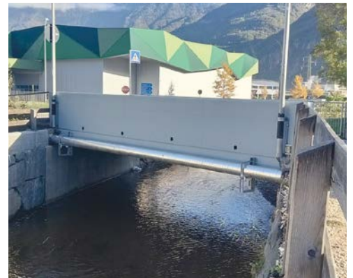
~ Eine der Maßnahmen zum Hochwasserschutz Quelle: Giorgia Mongillo
